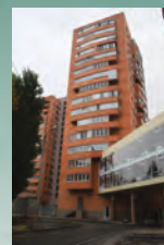
I очередь Жилого 3-х секционного комплекса, г. Харьков
